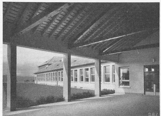
Abb. 6. Blick aus der Spielhalle gegen den Schulzimmerflügel.
