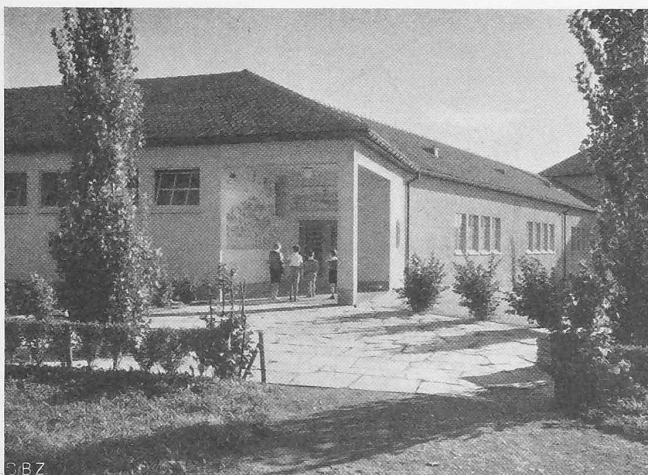
Abb. 5. Nördlicher Eingang des Schulhauses, von Witikon her.
