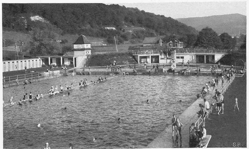
Abb. 5. Uebersicht über das Liestaler Schwimmbecken von der Restaurant-Terrasse.
