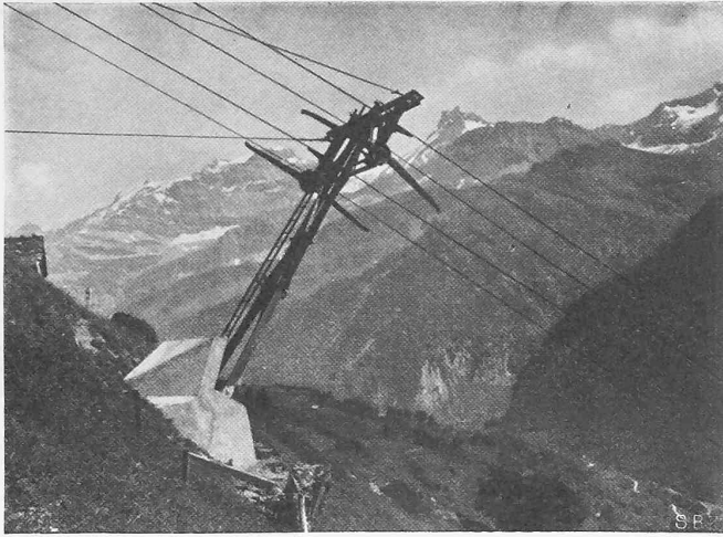
Abb. 2. Stütze der Luftseilbahn Spiringen-Ratzismatt am Klausen.
