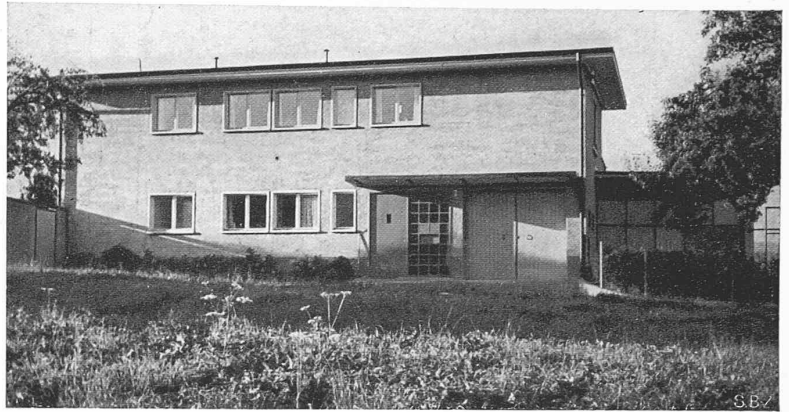
Abb. 4. Rückseite, rechts das Atelier des Hauses D. in Uetikon. — Arch. H. SUTER Abb. 5 (unten links). Treppenhause Abb. 6 (unten rechts). Südfront
