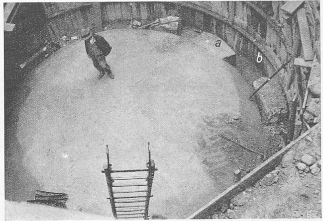
Abb. 11. Normalturm, die fertige Kuppel vor der Ueberdeckung. a Gewölbe über der Eingangstüre, b Spriessung des Voreinschnittes
