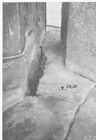
Abb. 5. Befund der Mauer nach Abheben der Bleiabdeckung
