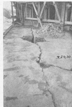
Abb. 5. Befund der Mauer nach Abheben der Bleiabdeckung
