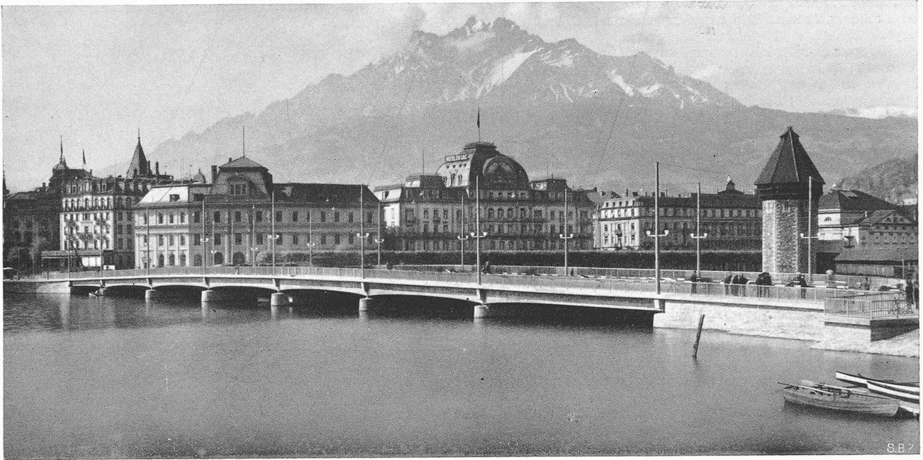
Abb. 6. Die erneuerte und verbreiterte Seebücke in Luzern, vom Schweizerhofquai gegen Südwesten gesehen
