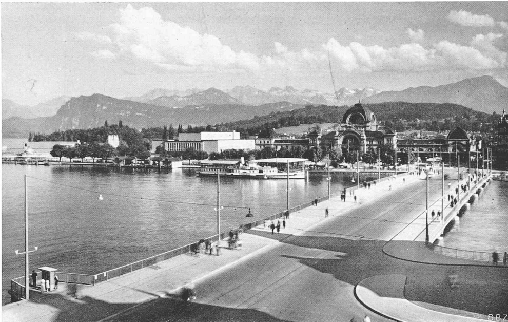
Abb. 8. Die verbreiterte, neue Seebücke, gegen Südosten (Bahnhof und Konzerthaus)
