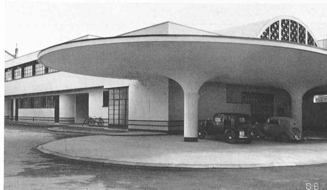
Fig. 6. Parc à voitures couvert en forme de champignon
