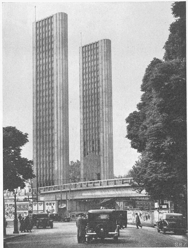
Abb. 8. Die Holztürme am Ausstellungseingang Place de l'Alma
