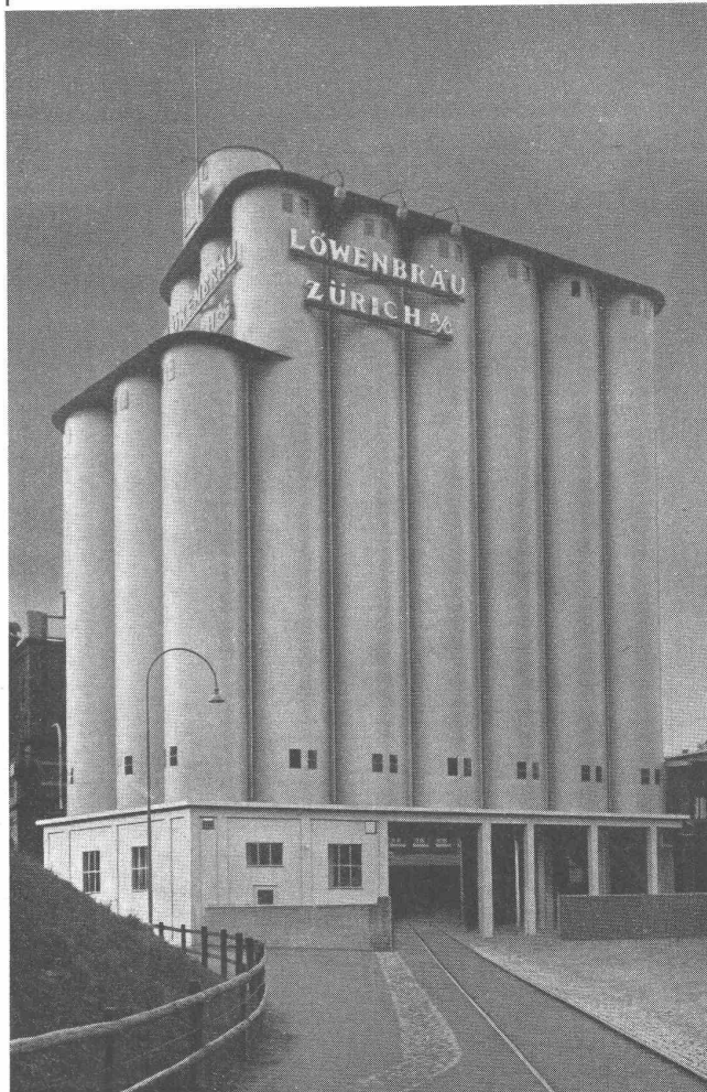
Silo-Anlage von 4500 m 3 Inhalt
