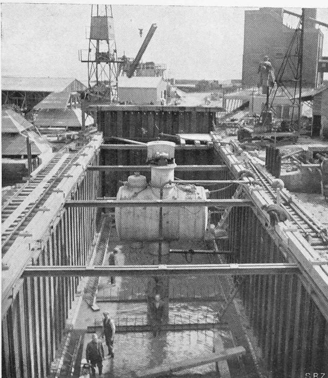
Abb. 8. Absenkung des Trockendocks (vergl. Abb. 5, II. Etappe).
