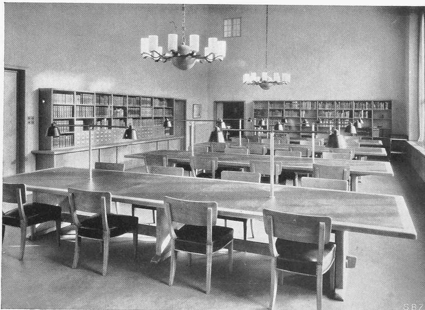
Abb. 14. Lesesaal des Kupferstich-Kabinetts im Erdgeschoss. Wände Kalkabrieb mit Patentfarbenanstrich, Türen und Mobiliar Ulmenholz, Stühle und Tische matt-schwarzbraun lederbespannt, Lampen schwenkbar, Boden braunrot Korklinoleum von Giubiasco.
