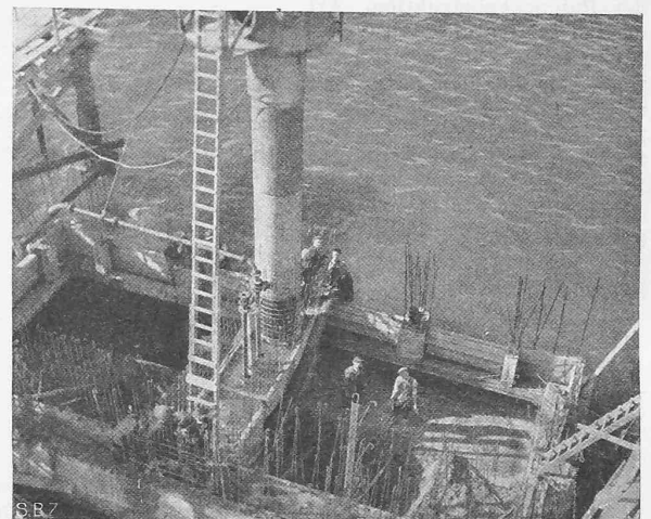
Abb. 12. Caisson der Wasserfassung nach dem Einschwimmen; Ebbe.
