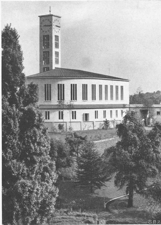
ANSICHT AUS NORDWEST
