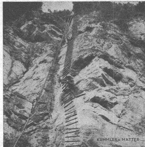
Kabelverlegung am Brünig
