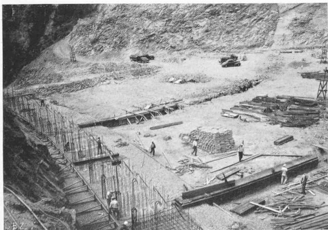
Abb. 13. Entlastungsanlage, oberer Teil im Bau, stromabwärts
