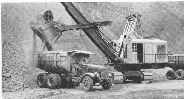
Abb. 7. 19\frac{1}{2} m 3 -Lastwagen, beladen durch 3 m 3 Diesel-Schaufel
