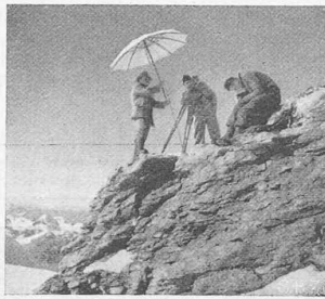
Abb. 8. Triangulation des obren Axpunktes des Schachtes zur Bestimmung seines Fusspunktes
