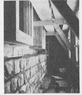
Abb. 14. Betonierte Fenster- und Vormauerung
