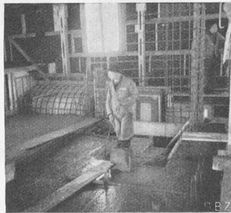
Abb. 12. Betonieren der Decke über I. St., I. hinten Thermometer-Nische
