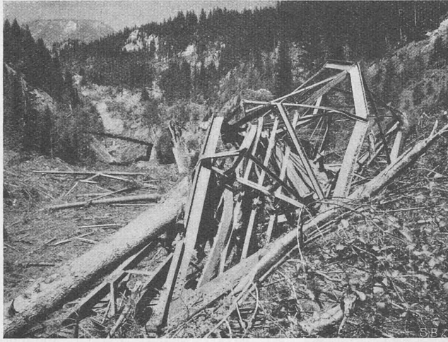
Abb. 14. Durch eine Lawine etwa 200 m weit abwärts geschobene eiserne Strassenbrücke im Safiertal (links oben die Hilfsbrücke)
