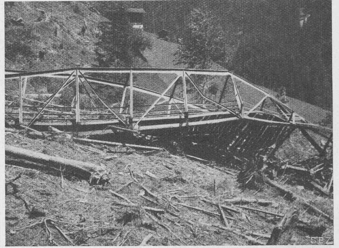
Abb. 14. Durch eine Lawine etwa 200 m weit abwärts geschobene eiserne Strassenbrücke im Safiertal (links oben die Hilfsbrücke)
