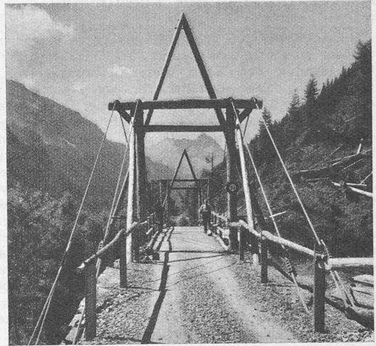
Abb. 16. Hängebrücke in Holzbau, erbaut von Prader & Co. (Chur), als Hilfsbrücke anstelle der zerstörten eisernen im Safiertal
