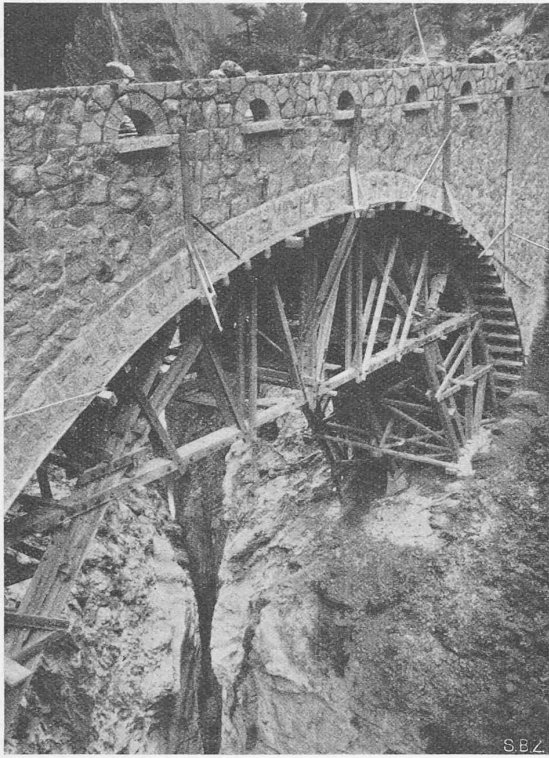
Abb. 7. Gerüst und Aufbau der neuen «zweiten Brücke» in der Viamala ob Thusis, links taleinwärts, rechts talauswärts gesehen
