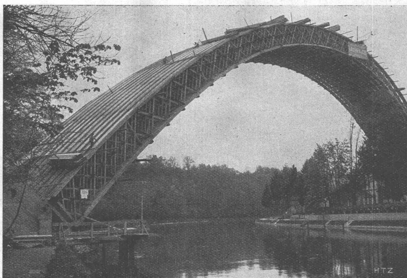
Aarebrücke SBB. Bern, Lehrgerüst
