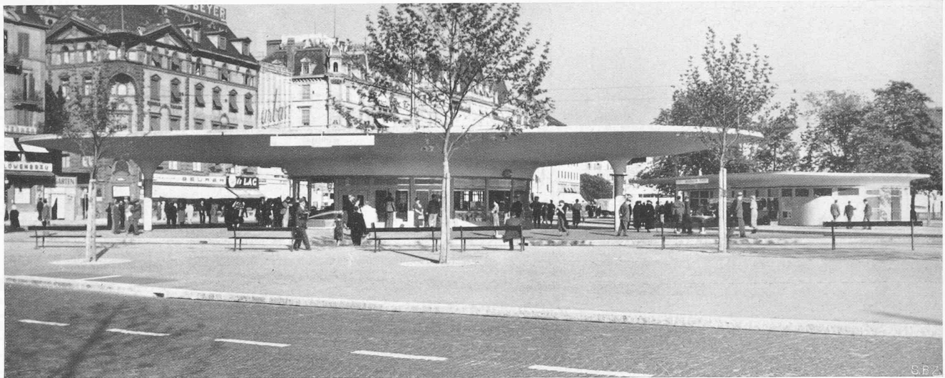
Abb. 5. Gesamtbild der neuen Wartehalle am Bellevue-Platz in Zürich, aus Nordwest, gegen die Theaterstrasse, rechts das Dienstgebäude
