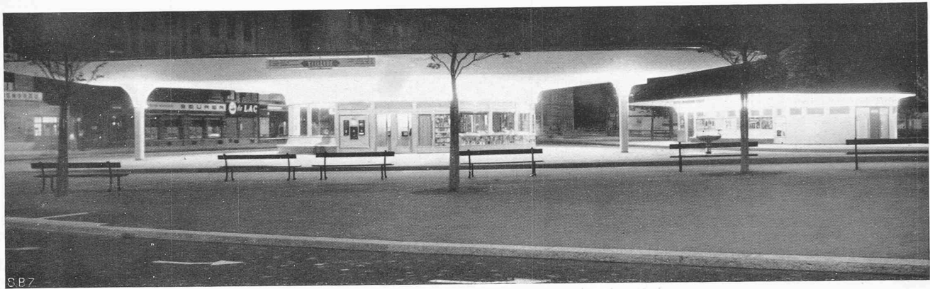
Abb. 10. Die neue Wartehalle und (rechts) das Dienst- und Klosettgebäude am Bellevueplatz Zürich, indirekt beleuchtet
