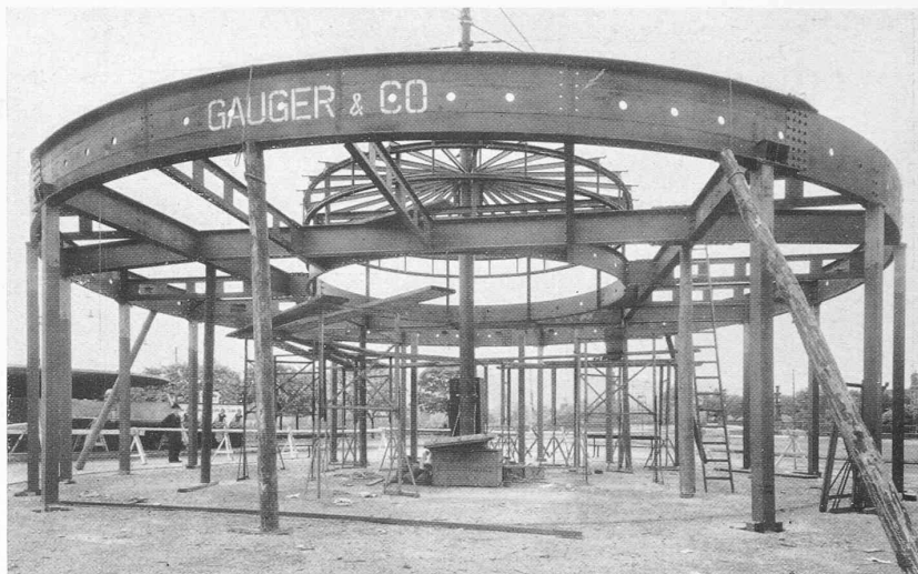
Abb. 3. Die mittleren Ringstützen, Bauzustand am 4. Oktober 1937
