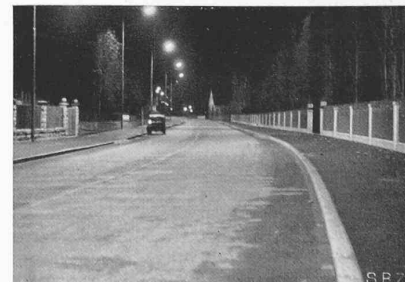
Abb. 2 (rechts) Zürichseestrasse bei Meilen mit «Philora»-Natriumdampflampen S O 650
