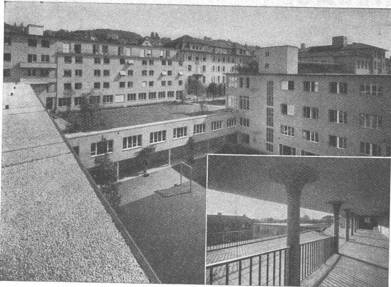
Schweiz. Pflegerinnenschule Zürich Architekten: Gebr. Pfister, Zürich
