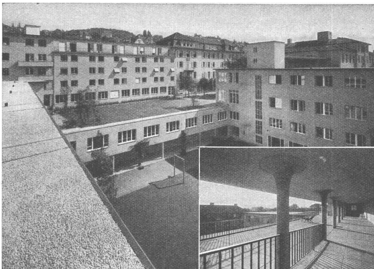
Schweiz. Pflegerinnenschule Zürich Architekten: Gebr. Pfister, Zürich
