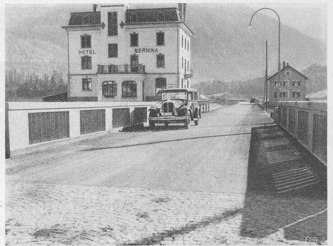
Abb. 19. Innbrücke Celerina, gegen Pontresina gesehen
