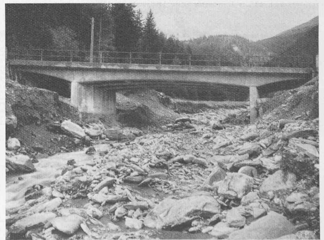
Abb. 24. Plattenbalken-Brücke im Val Ruinains, Unterengadin
