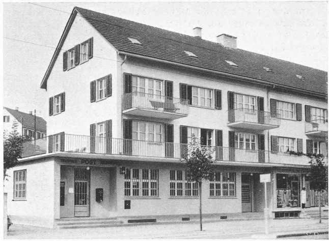
Abb. 43. Postbureau Oberwinterthur, Mietlokal in einem Neubau
