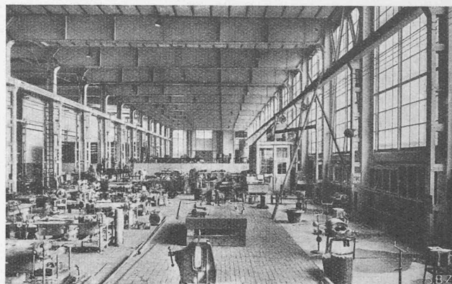
Abb. 2. Werkstattgebäude (1930) bei Gebr. Sulzer, Winterthur
