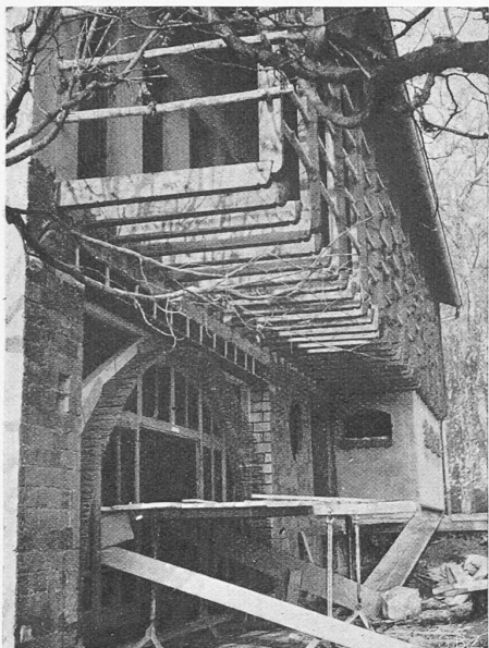
Abb. 66. Laube am Grotto (im Bau)
