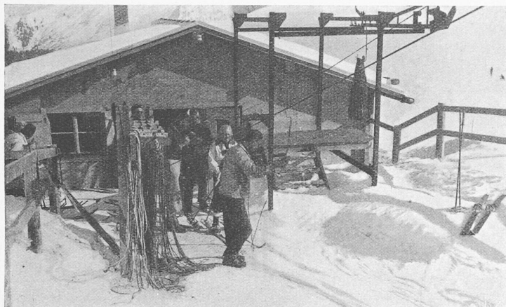
Abb. 9. Anhängen der Fahrgäste in der untern Station
