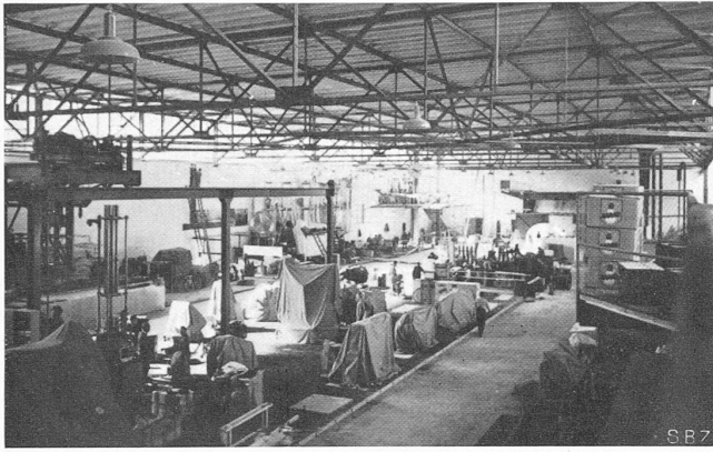
Abb. 36. Blick in die nordwestliche Ecke der grossen Maschinenhalle
