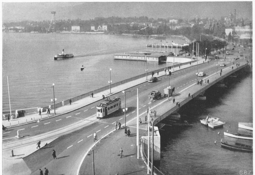
Abb. 60. Die neue Quai-Brücke in strengster Sachlichkeit. Arch. GEBR. PFISTER, Zürich
