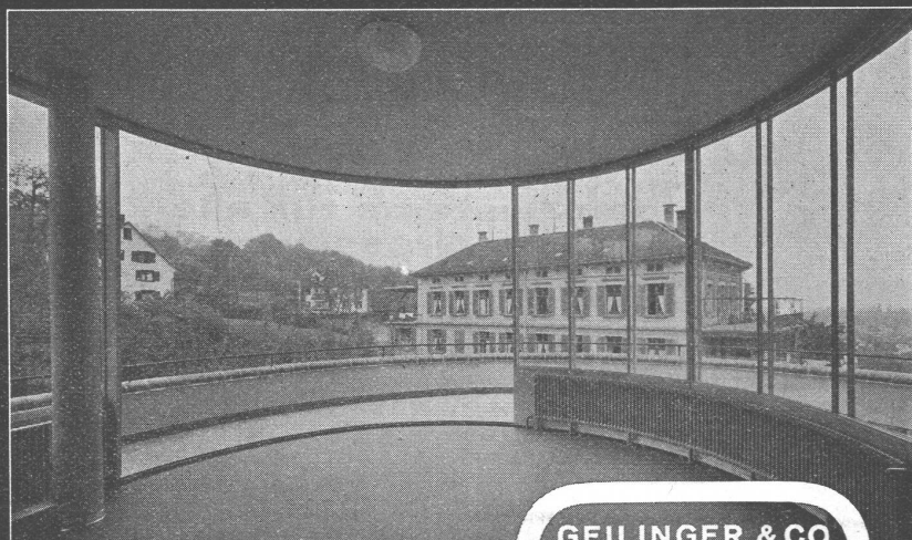
Spital Wädenswil / Liegehalle Schiebefenster
