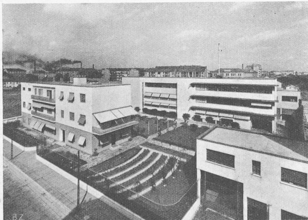
Abb. 15. Links Bureaux und Wohnung, Mitte Fabrik, rechts Portier. Chocolats ITALCIMA Mailand, Arch. L. BALDESSARI
