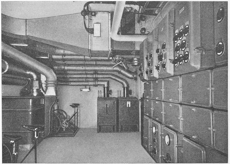
Abb. 2. Teilansicht des Maschinenraumes eines Gasschutzkellers für 300 Personen. Links LUWA-Gasfilter mit vier Veloantrieben, die für die Belüftung genügen. Im Hintergrund zwei methodische CO<sub>2</sub>-Absorbiergeräte, System LUWA. An der Decke Luftkanal für die Konditionierung der Luft, mit eingebauter Kühl- bzw. Heizbatterie. Rechts Schalttafel zur Bedienung der Generatorengruppe mit Dieselantrieb und des Luftkompressors
