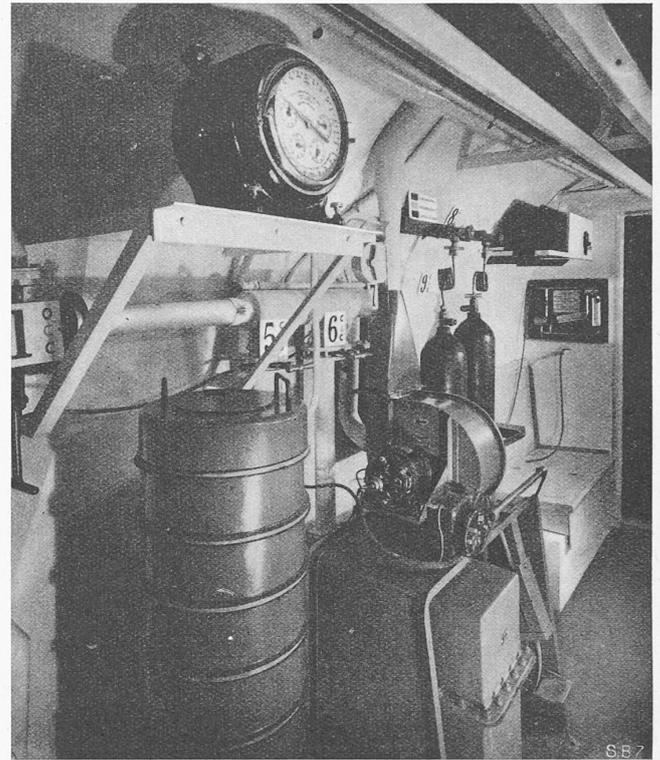
Abb. 7. Maschinelle und Ventilations-Einrichtungen für einen Schutzraum für 20 Personen. — Links methodisches CO<sub>2</sub>-Absorbiergerät, oberhalb Gasuhr für die Kontrolle des Sauerstoffzusatzes, rechts LUWA-Kampfgasfilter mit aufgebautem Ventilator für Motor- und Fussantrieb. Im Hintergrund Sauerstoff-Flaschen, Ueberdruckmesser, Gasdetektor. An der Decke Kühlschlangen, um Feuchtigkeit und Temperatur bei starker Besetzung zu vermindern
