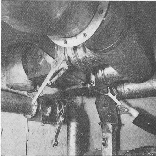
Abb. 1. Luftverteilungsleitungen mit luftdicht schliessenden Schnellschlussklappen mit Festhaltemechanismus
