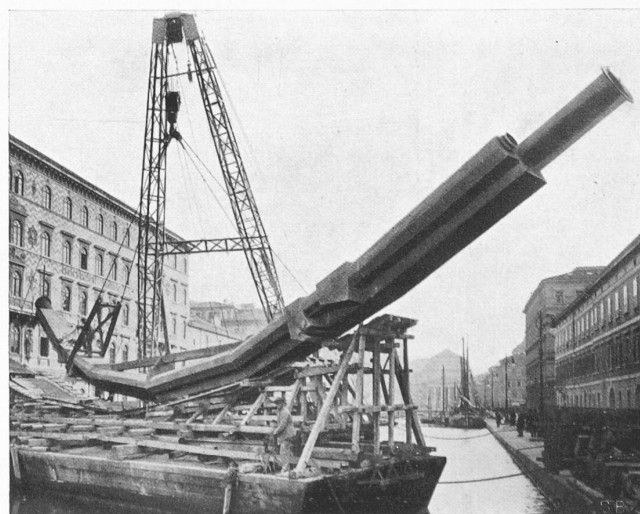
Abb. 2. Eisenbeton-Dücker von 40 t, fertig versetzt in eine Kanalsohle Entwurf von Ing. LUDW. GSCHWEND, G. E. P. (von St. Gallen) in Triest
