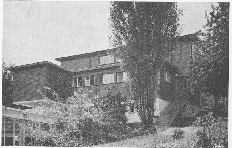
Abb. 3. Nordostseite der Kinderkrippe Lindt & Sprüngli, Kilchberg
