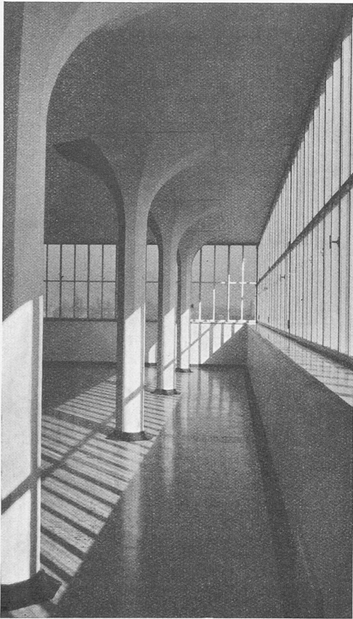
Stützenfreie Fensterwand im Betriebsgebäude Hoffmann - La Roche, Basel. — Prof. O. R. SALVISBERG. — Lift-Turm, rechts altes Bureaugebäude
