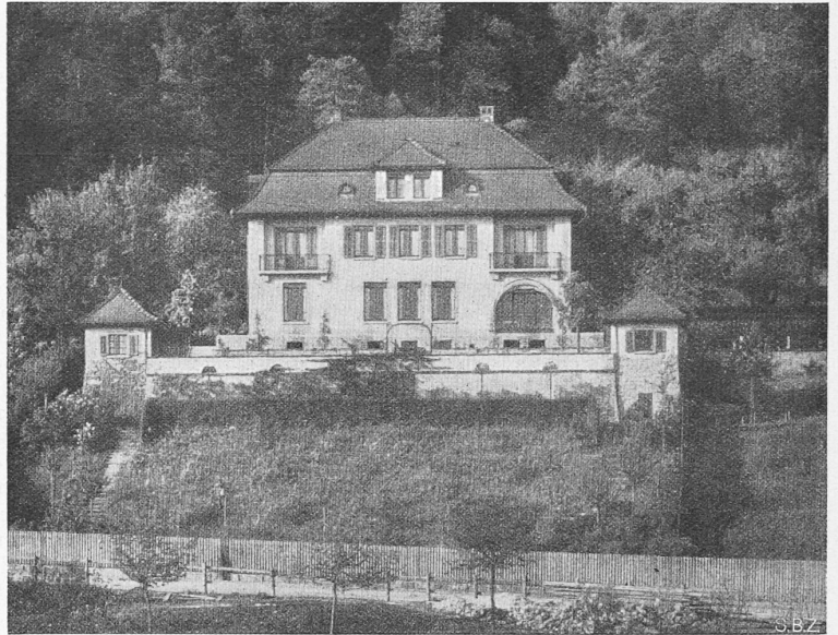
Erstes Eigenheim «im Guggi» von Arch. Max Haefeli, Zürich (1910)
