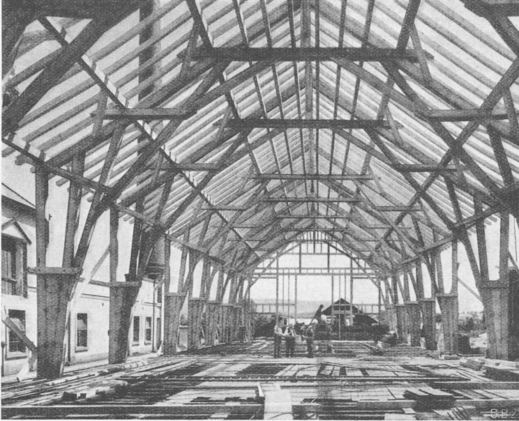
Abb. 3. Durchblick durch die Halle im Rohbau
