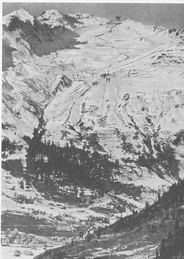
Abb. 1. Gesamtbild der Parsennbahn aus Südost. — D Davos-Dorf, H Umstiegstation Höhenweg, W Endstation Weissfluhjoch 2662 m ü.M.
