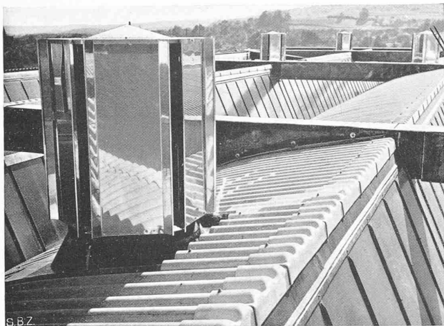
Abb. 13. Kupferne Lüftungshauben im Welleternitdach
