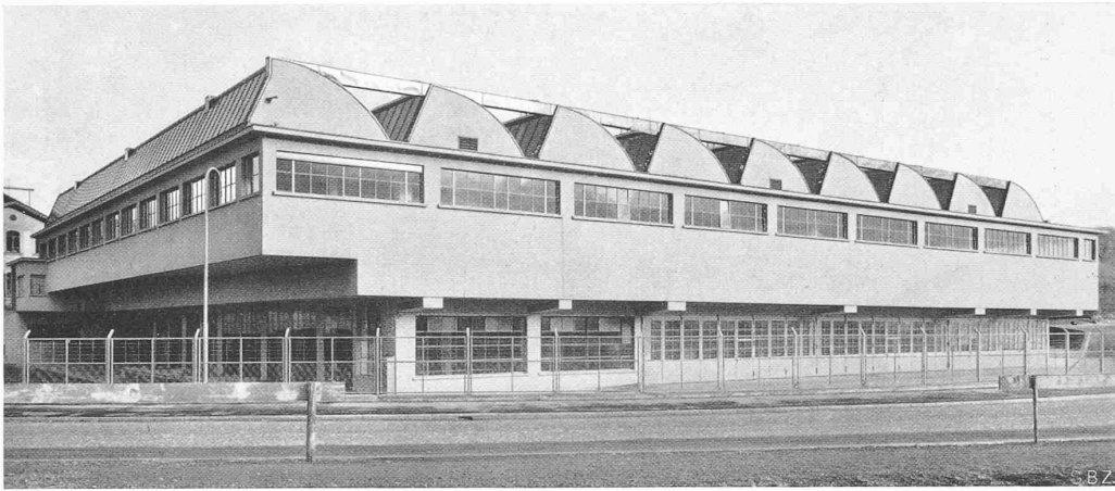
Abb. 1. Erweiterungsbau der Schweiz. Bindfadenfabrik Schaffhausen, erstellt durch LOCHER & CIE., Zürich
