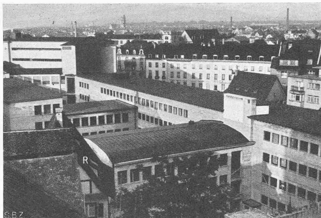
Abb. 3. Gesamtbild aus Südwest, im heutigen Bauzustand
