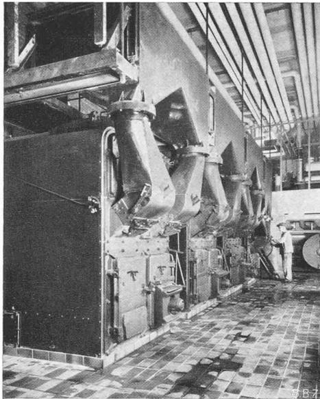
Abb. 38. Drei Sulzer-Heizkessel für 3 Mill. Cal/h
