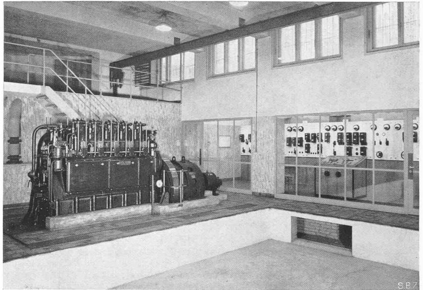
Abb. 37. Sulzer-Diesel-Notstromgruppe und elektrische Schaltzentrale im 2. Keller
