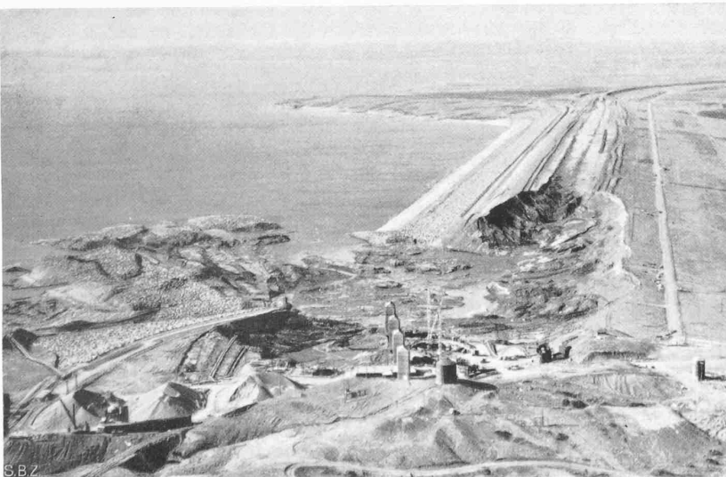
Abb. 12. Dammbbruch am Fort Peck-Damm; wasserseitige Böschung 1:4
