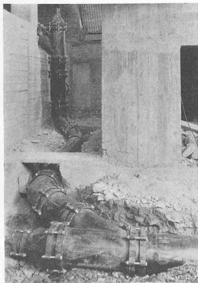
Abb. 17. Kombination von Eternit und Guss-Formstücken im Kantonspital Chur
