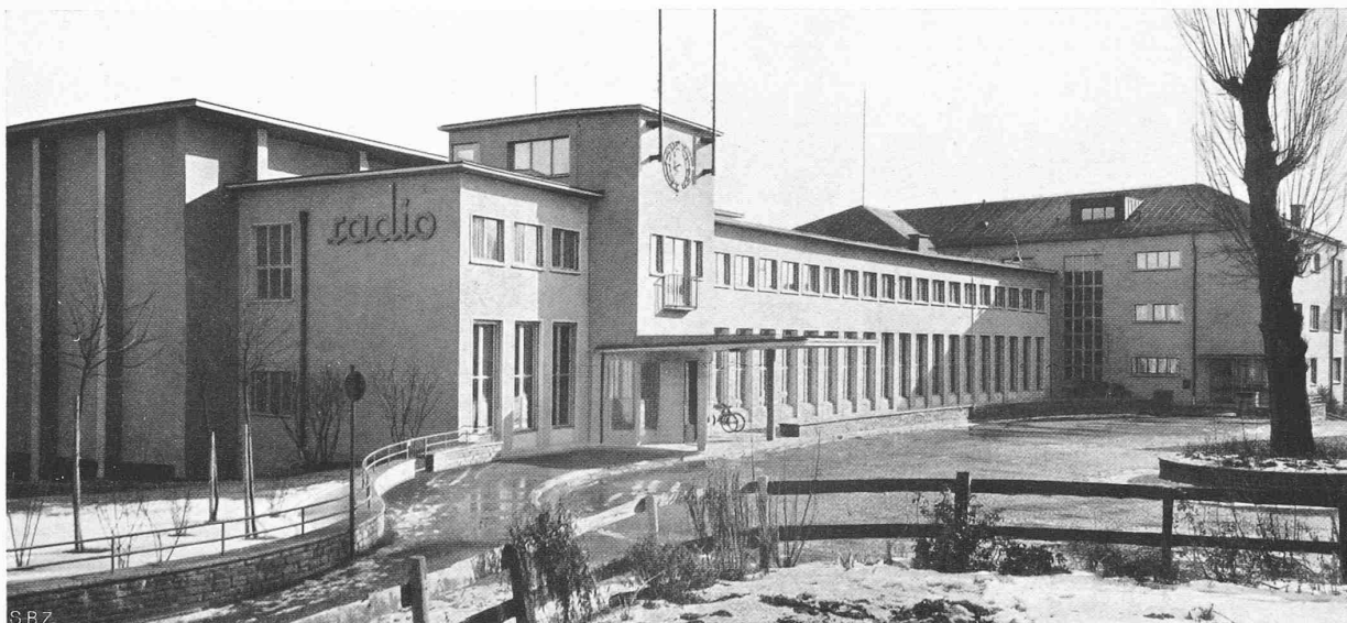
Abb. 1. Vorn links der Erweiterungsbau mit Haupteingang, rechts hinten der querstehende Altbaufügel
