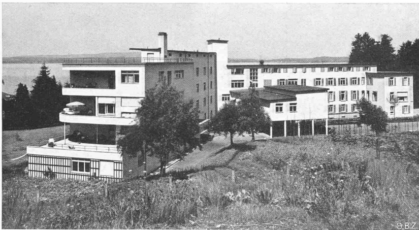
Abb. 5. Gesamtbild aus Südosten, Rückseite mit dem Operationsflügel
