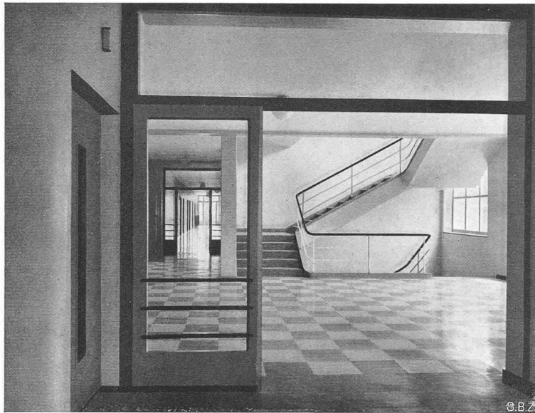
Abb. 13. Treppen-Halle, vom Personen-Lift in den Korridor des Altbaues
