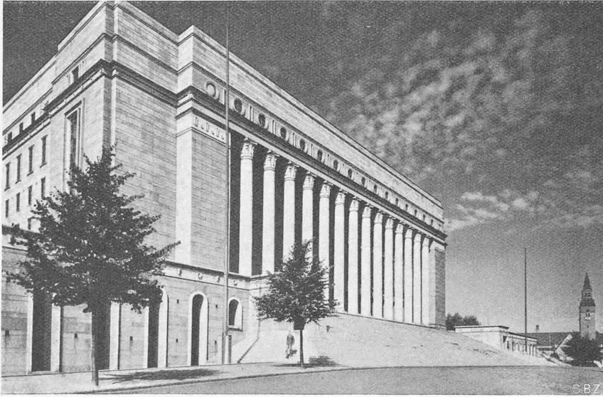
Abb. 1. Das finnische Reichstagsgebäude in Helsinki (1931), Arch. Prof. J. S. Sirén, Helsinki
