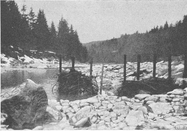
Abb. 16. Sporen aus eingerammten Eisenbahnschienen
