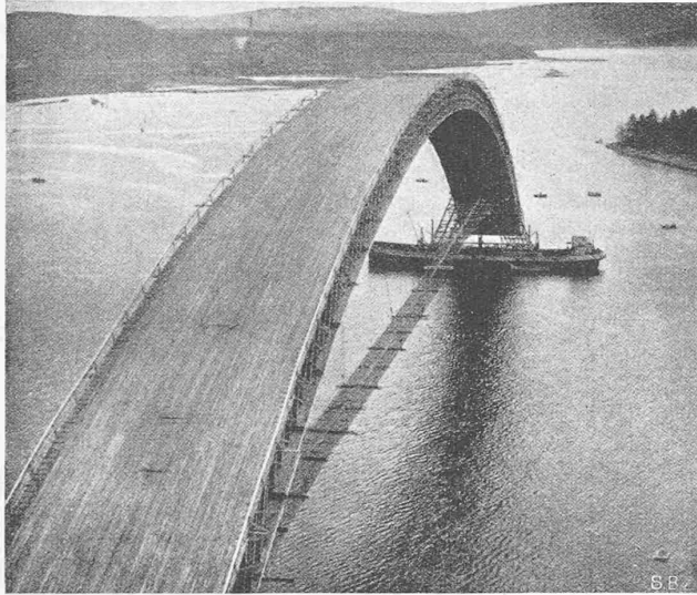
Abb. 7. Das Lehrgerüst der Sandöbrücke beim Einfahren
